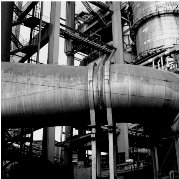
Kompensator in einer Leitung zum Hochofen
