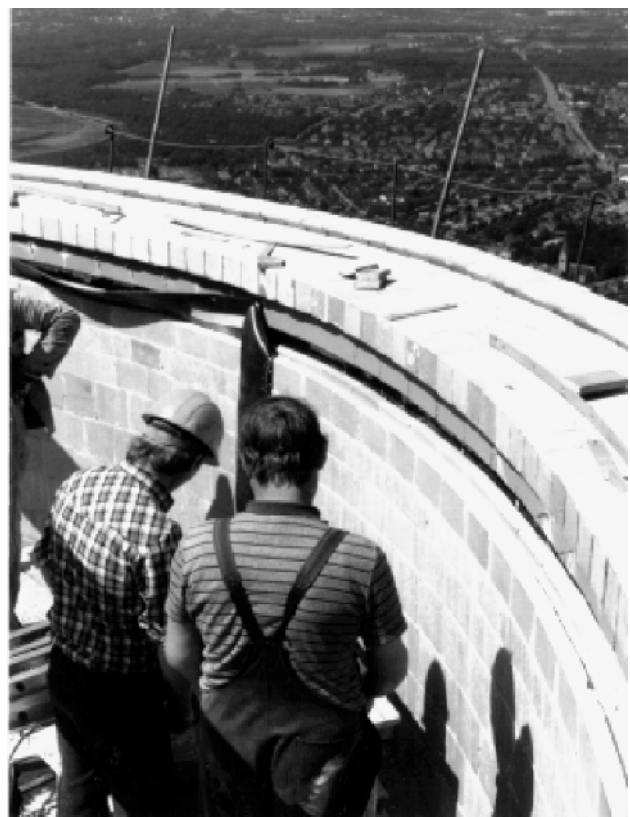
Monteure beim Einbau einer Futterstoß-Abdichtung.
